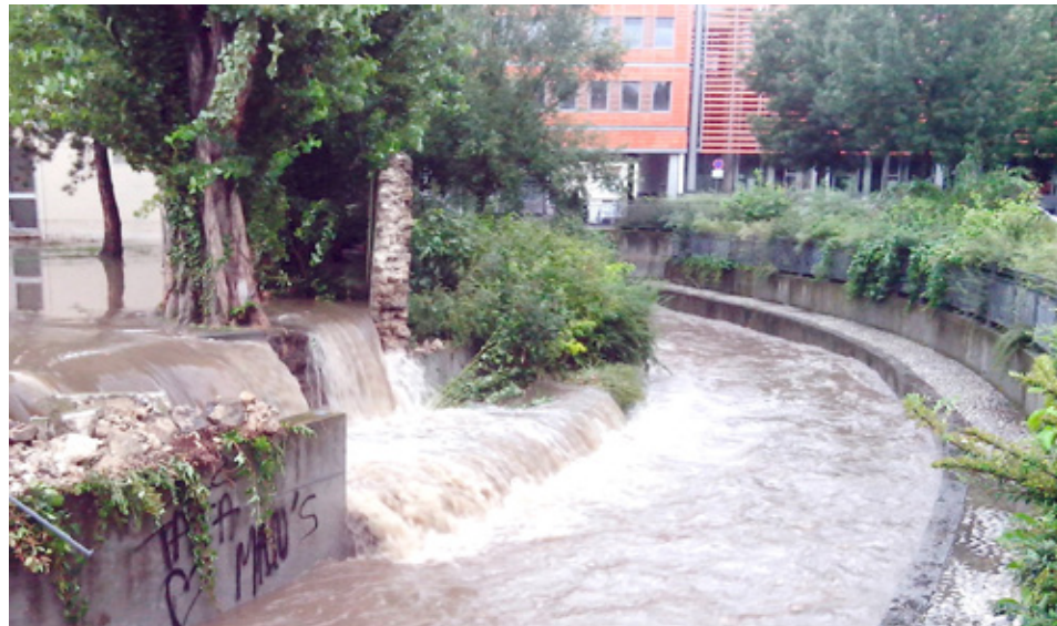
Le 9 août 2014, après s'être jouée du mur de protection de Saint-Alyre, l'eau revient sur celui de la résidence du Peyrou. Photo : Jean-Nicolas AUDOUY.
